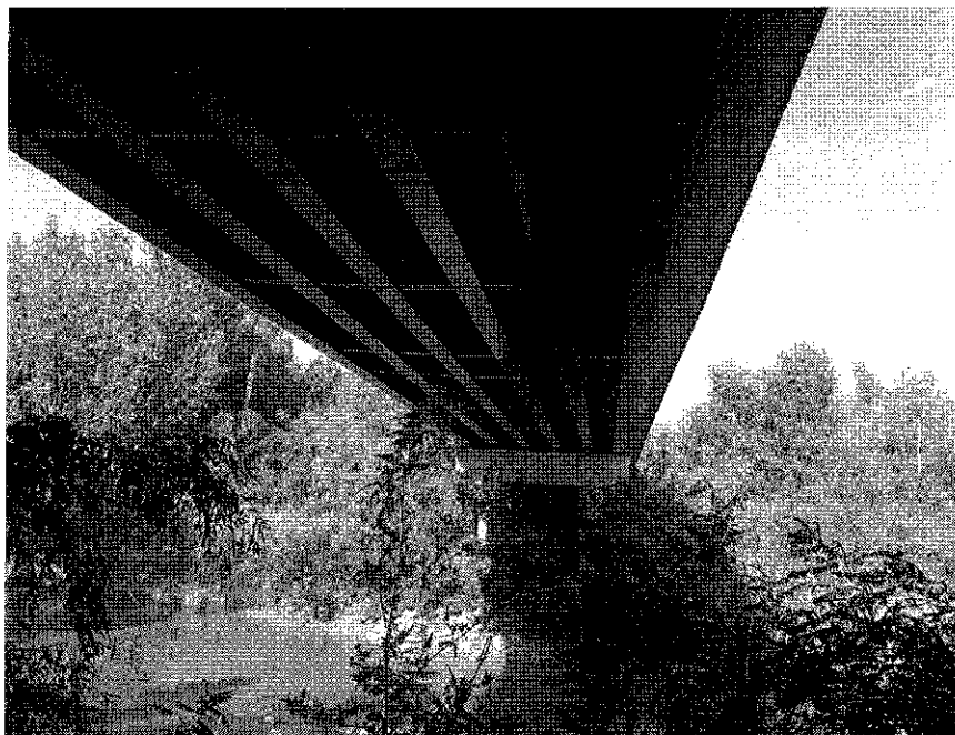
Figura 15. Vedere deschidere centrala (executata in 2010).
