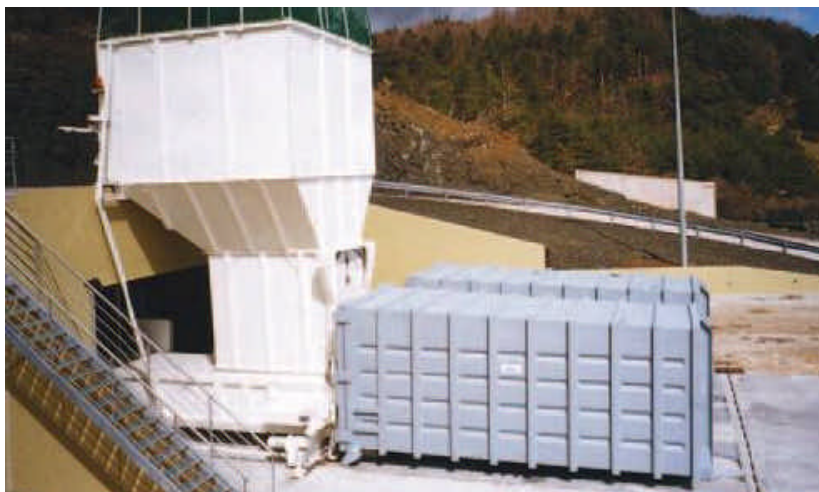
Figura 5-6 Statie de transfer cu sistem semiautomat
