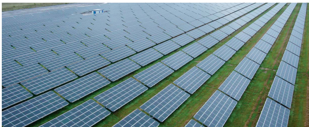
Fig 3.1 – Parcuri Solare Fotovoltaice incurajand cresterea ierbii
